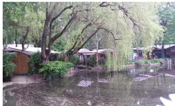
Foto 10: Dichte Bebauung mit Ferienhütten bis an das Ufer des Brettmühlenteiches
