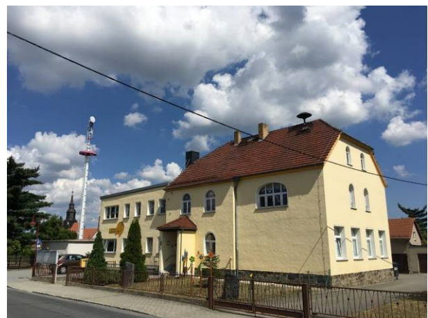
Foto 6: Kita Tauscha und Richtfunkmast
