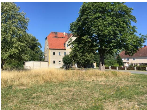
Foto 5: Ehemaliges Herrenhaus, Vorderansicht
