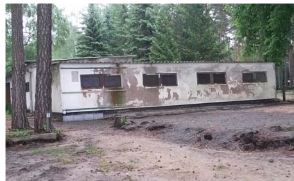
Abb. 14: Bauhof (Blick vom Strand)
