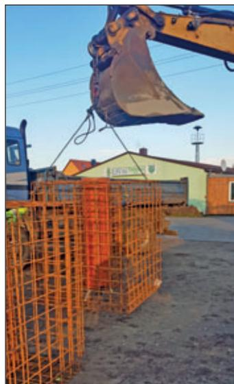
Firma Hausdorf beim Einbau der Stahlkörbe für die Mastenfundamente
