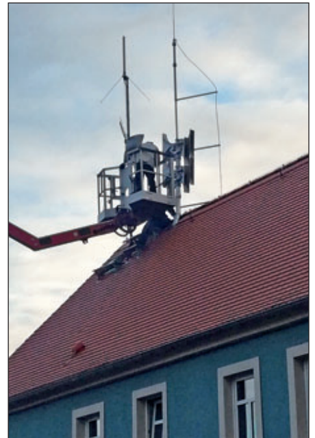
Austausch der Sirene auf der Polizei-Station Thiendorf am 06.12.2018. Die neue Sirene verfügt über ein Sprachmodul, worüber bei Bedarf eine Sprachdurchsage erfolgen kann. 2018 wurde außerdem eine neue Sirene am Feuerwehrgerätehaus in Stölpchen errichtet.
