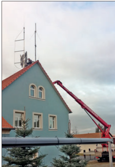
Austausch der Sirene auf der Polizei-Station Thiendorf am 06.12.2018. Die neue Sirene verfügt über ein Sprachmodul, worüber bei Bedarf eine Sprachdurchsage erfolgen kann. 2018 wurde außerdem eine neue Sirene am Feuerwehrgerätehaus in Stölpchen errichtet.
