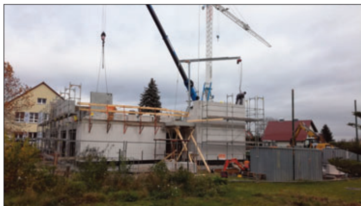
Errichtung Wände 1. OG – Hortneubau Ponickau
