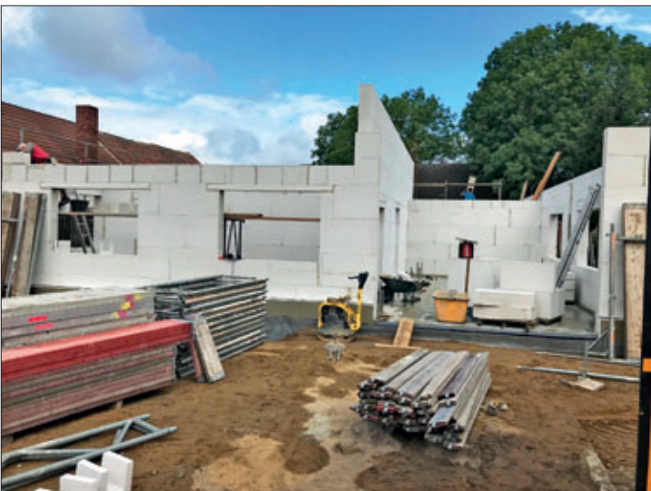
Der Haupteingang entsteht auf der linken Gebäudeseite, vor dem Gebäude werden später 3 Parkplätze angeordnet
