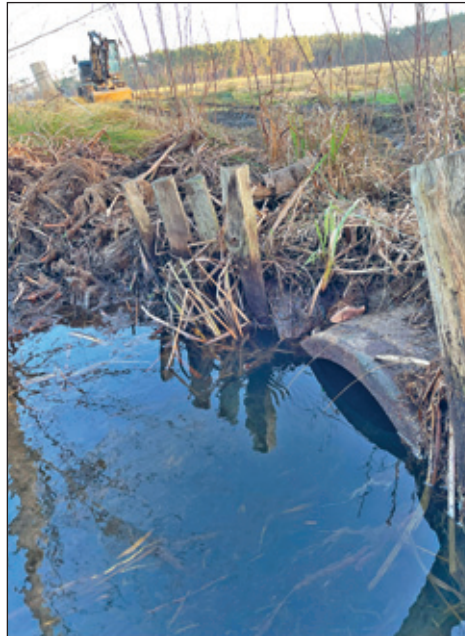
Der Wasserstand wurde um 40 cm abgesenkt durch die Reinigung des Flusslaufes
