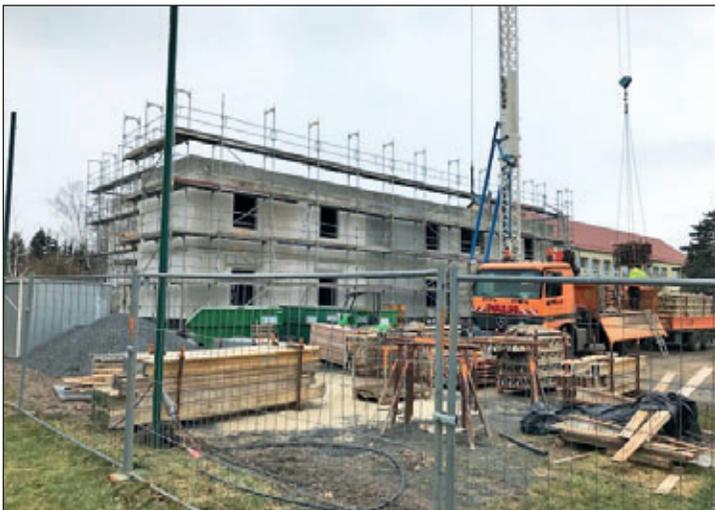
Am Hort in Ponickau wurde der Rohbau, bis auf Restarbeiten, fertiggestellt. Als nächstes werden die Fenster eingebaut. Sobald die Gebäudehülle geschlossen ist, wird der Innenausbau beginnen. Erfreulicherweise bewegen wir uns mit einer Abweichung von 14 Tagen innerhalb des gesteckten Zeitplanes.
