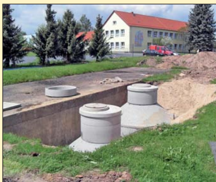
Errichtung einer biologischen Kleinkläranlage für die Schule, den Kindergarten und Wohneigentümergeinschaft in Ponickau
