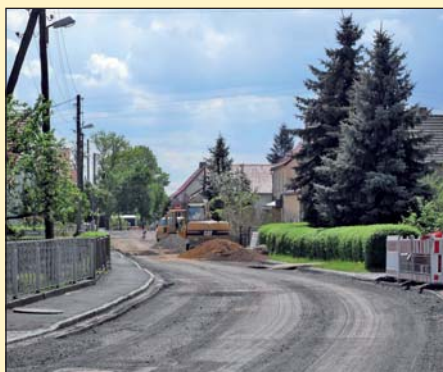
Auf der Straße Zum Oberdorf in Sacka haben die Straßenbauarbeiten begonnen.
