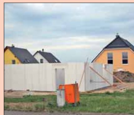
Bodenplatte mit ersten Fertigteilen der Familie Löscher
