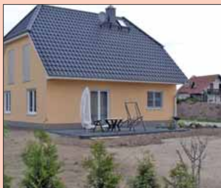
Fertiggestelltes Wohnhaus der Familie Woida
