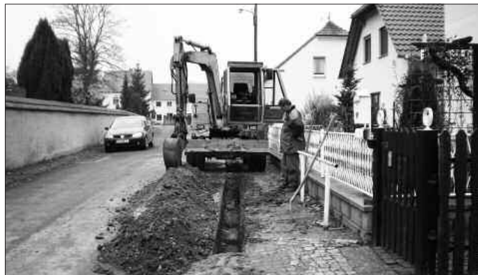
Erneuerung der Straßenbeleuchtung durch den Bauhof in Ponickau, Ortrander Straße
