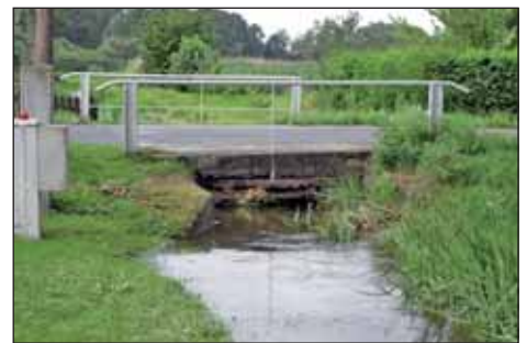
Jetzige Brücke in Welxande
