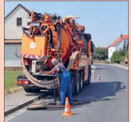
Kanalreinigungsarbeiten im Ortsteil Welxanda
