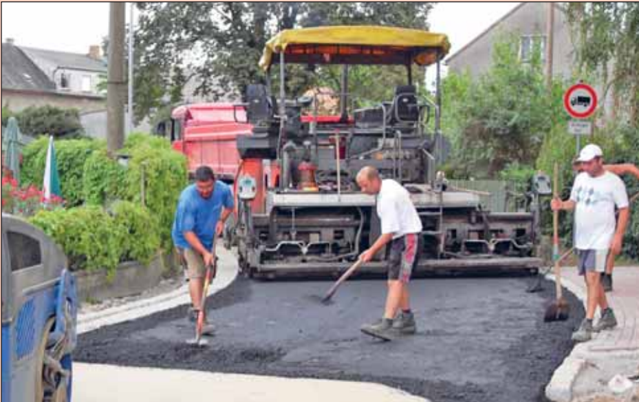
Aufbringen der Schwarzdecke auf der Rosenbornstraße in Ponickau
