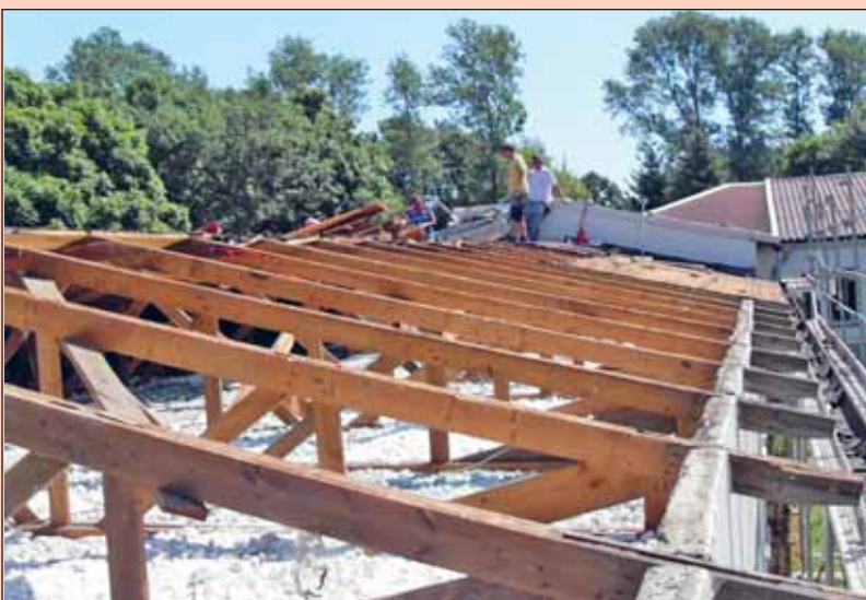
Beginn der Dachdeckerarbeiten am Kindergarten Thiendorf durch die Firma Morgenrot aus Großenhain
