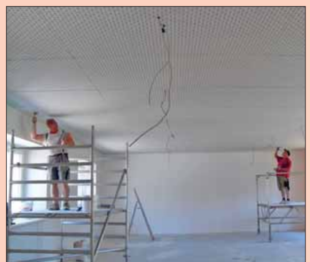
Anbringen der Akustikdecke im Dorfgemeinschaftshaus Ponickau durch die Mitarbeiter der Firma Beeg aus Röders
