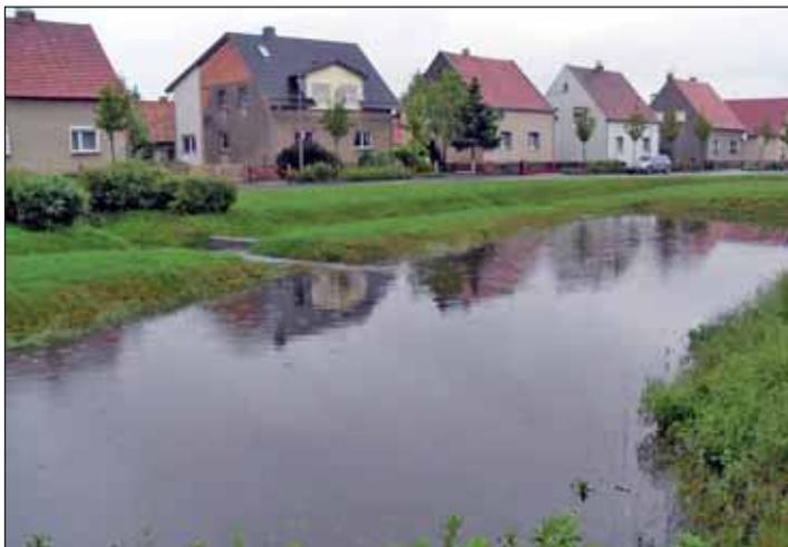
Das Rückhaltebecken in Ponickau wurde im Zuge des Straßenbaues geschaffen. Durch den angeordneten Querriegel mit einem max. Durchlass von 20 l/sek. wird ein Zulauf des Beckens erzielt. Die oftmals hinterfragte geringe Durchflussmenge basiert auf hydraulischen Berechnungen, welche letztendlich wasserrechtlich festgelegt wurden. Mit der Anlage des Beckens in der 1. Ausbaustufe besteht die Möglichkeit 400 m<sup>3</sup> Wasser zurückzuhalten und somit einen Rückstau in
