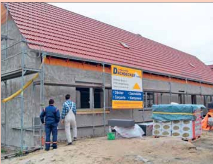
Beginn der Putz- und Dämmarbeiten durch die Firma Carsten Steinborn am Dorfgemeinschaftshaus Ponickau, rechts im Bild Wärmedämmarbeiten am Dorfgemeinschaftshaus Ponickau
