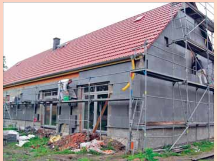
Beginn der Putz- und Dämmarbeiten durch die Firma Carsten Steinborn am Dorfgemeinschaftshaus Ponickau, rechts im Bild Wärmedämmarbeiten am Dorfgemeinschaftshaus Ponickau
