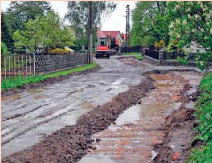
Beginn der Straßenbaumaßnahme auf der Rosenbornstraße in Ponickau
