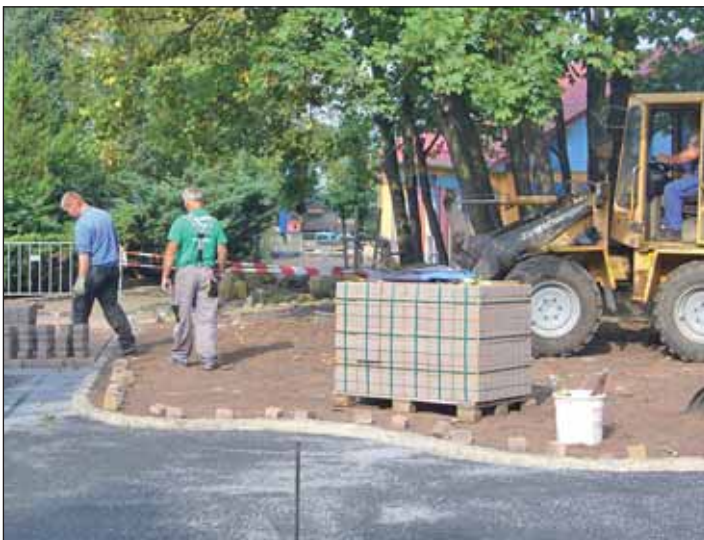
Eine Teilfläche der Außenanlage in der Thiendorfer Kinderereinrichtung wird durch Bauhofmitarbeiter umgestaltet. So erfolgt eine lang ersehnte Maßnahme der Erzieherinnen und unserer Kinder.
