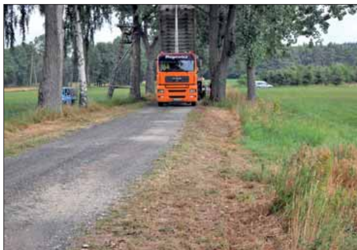
Aufbringen von Fräsgrut auf die Ortsverbindungsstraße von Sacka nach Röhrsdorf
