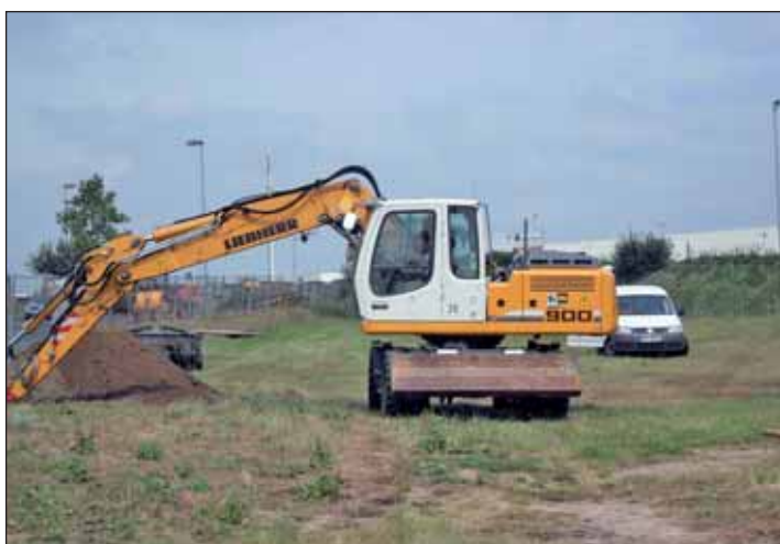
Baubeginn bei Burger King
