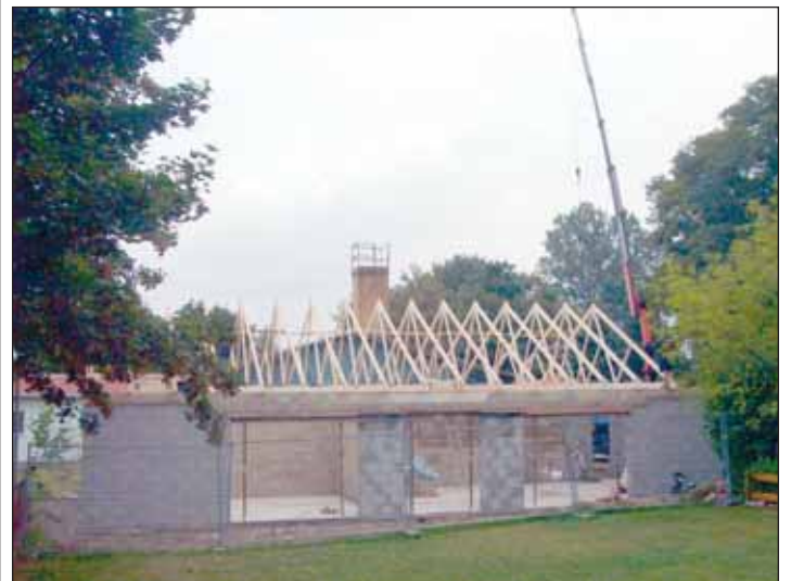
Aufstellen des Dachstuhls beim Anbau am Gebäude „Thiendorfer Kinderland“
