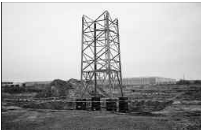
Errichtung eines Stahlgitter-Funkturmastes durch das Unternehmen O 2 in Thiendorf.
