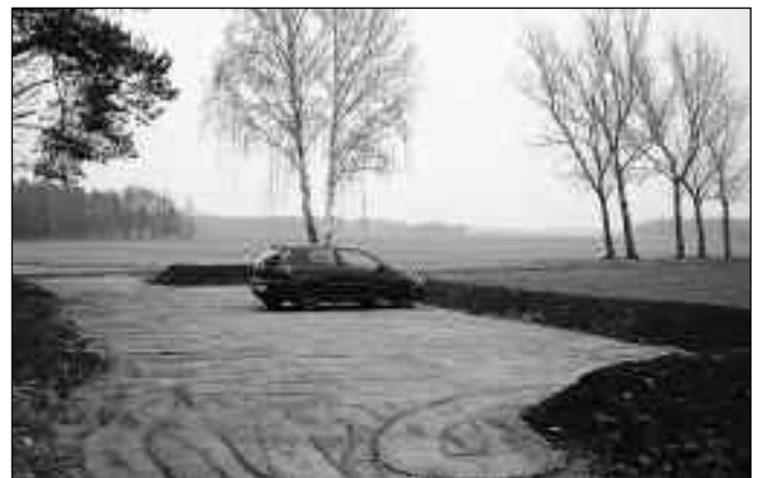
Bau eines PKW-Stellplatzes für Besucher des Schaufensters »Heidefeld-Zochau« sowie für Nutzer des Radweges.
